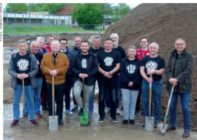
Sichtlich erfreut über den Start der Baumaßnahmen auf dem Vereinsgelände am Main zeigten sich der Präsident, die Vorstandschaft und verdiente Mitglieder des 1. FC Lichtenfels.
